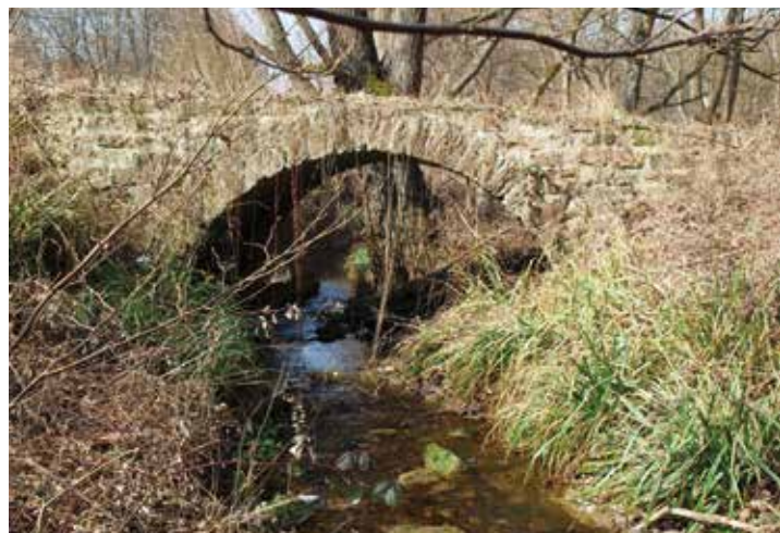
3 Bogenbrücke in Keltern-Dietlingen, Enzkreis
