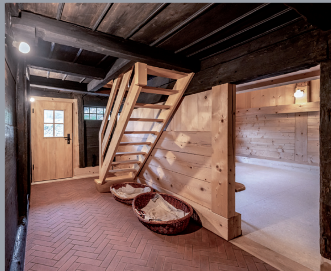
Eingangsbereich mit reparierter Ständer-Bohlen-Wand. Rechts der Blick in den umgenutzten Stallteil
