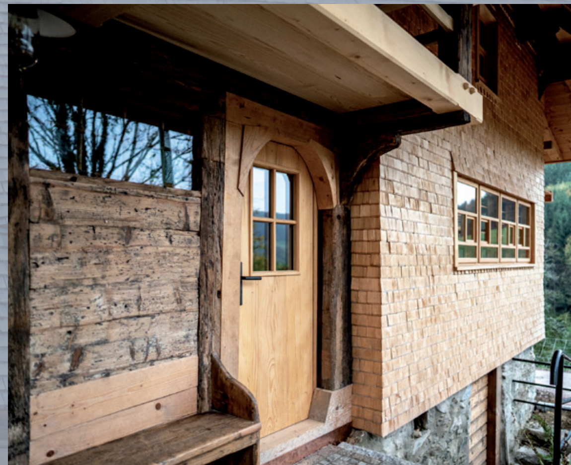
Saniertes Eingangsbereich mit Reparaturen am Trippel, alter Bohlenwand und neuer Verschindelung bei einem Hof in Elzach
