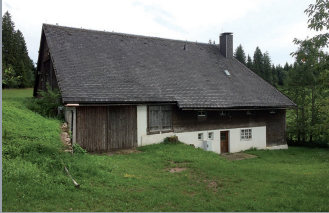
Schwarzwaldhaus in Gütenbach, Ansicht vor der Sanierung
