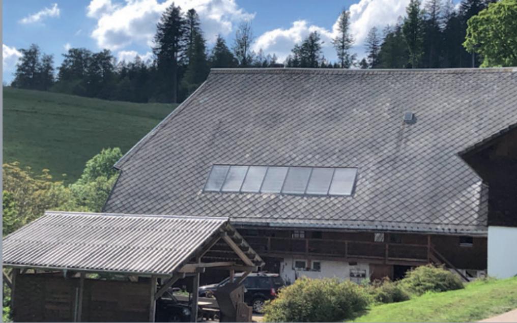
Hof in Unterkirnach, neue Belichtung des Dachraumes über eine kompakte Festverglasung
