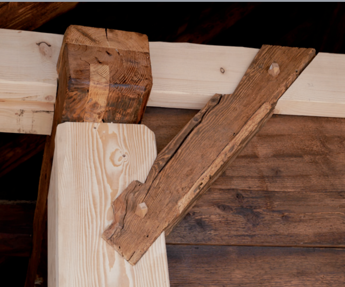
Detail einer reparierten Kopfstrebe an einem Hofgebäude in Oberried
