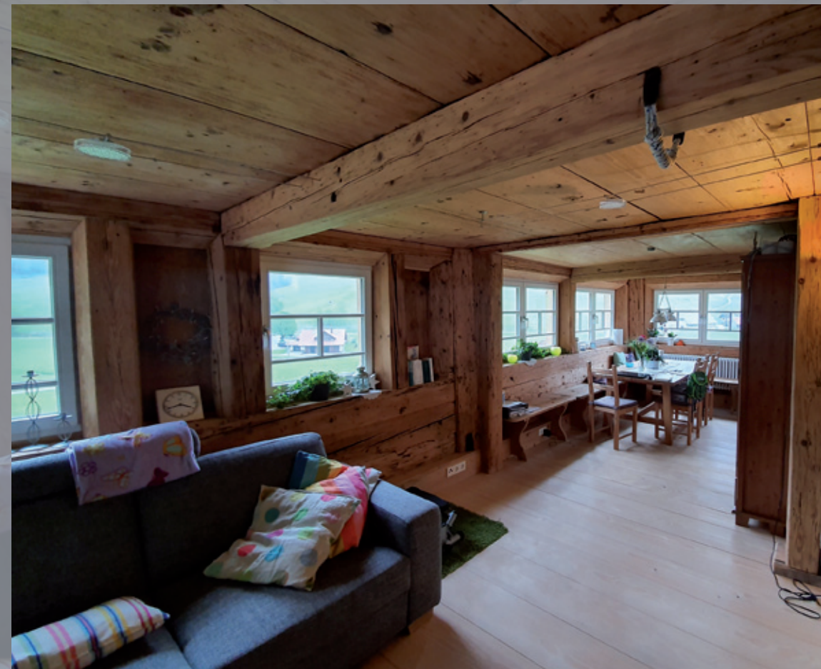
Wohnstube nach Sanierung und Umbau mit nach innen sichtbarer Ständer-Bohlen-Konstruktion
