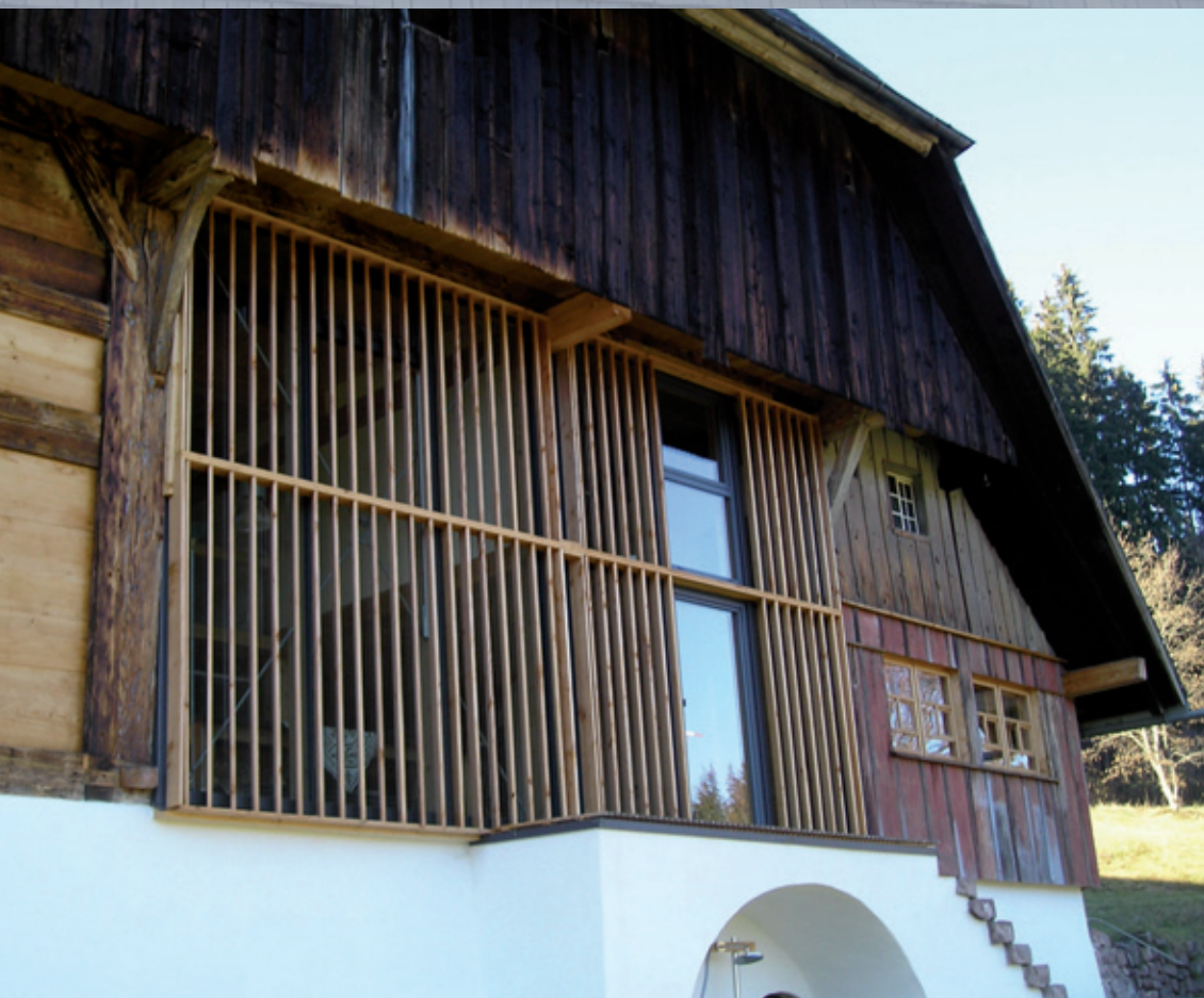
Neu gestaltetes Element an einem Hof in Schachenbronn für Ausgang und Belichtung
